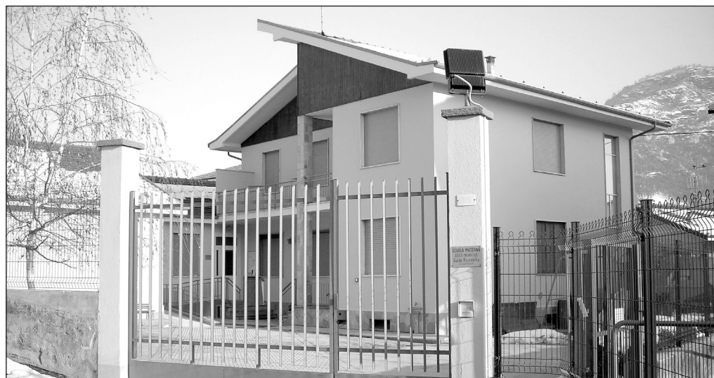
Forse già nel corso dell'anno 2010 saranno realizzati i lavori della nuova mensa
