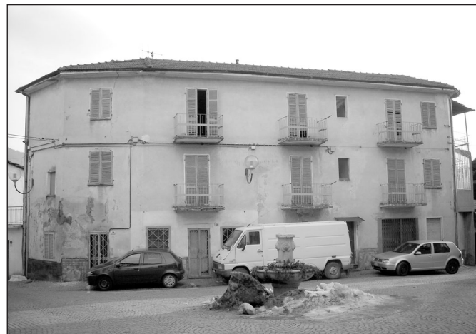
L'edificio di piazza Cesare Battisti sarà ristrutturato
