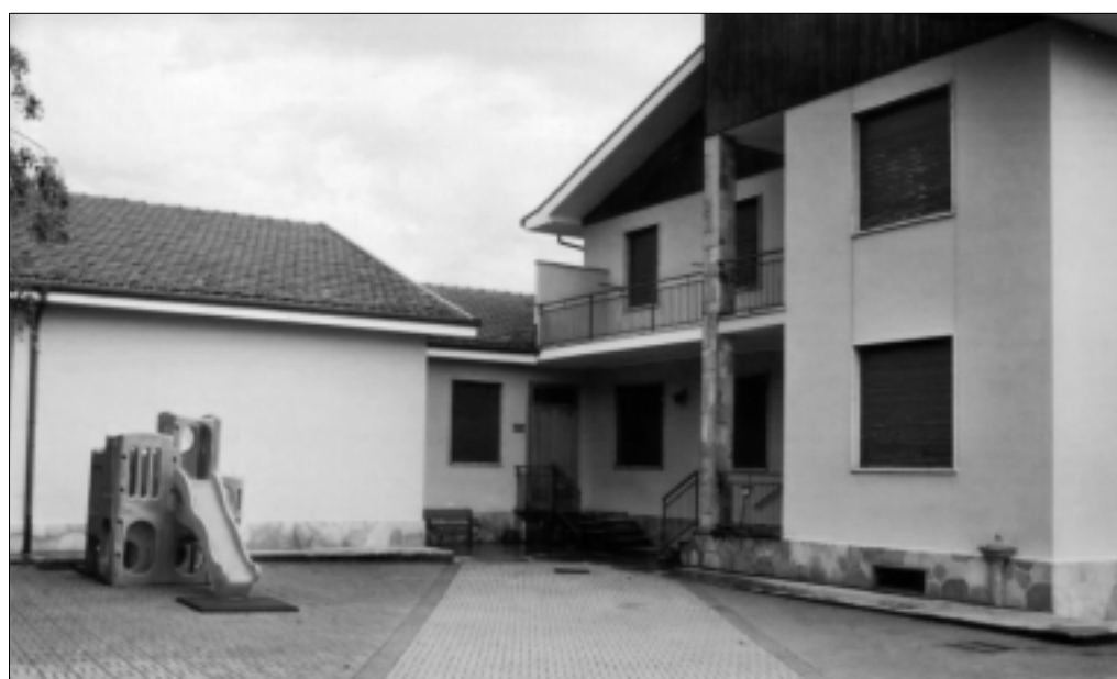
tra i principali interventi in programma c'è l'adeguamento dell'asilo infantile
