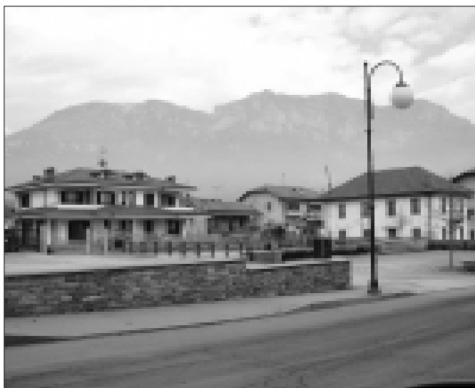
presto i lavori sulla nuova piazza di corso marconi
