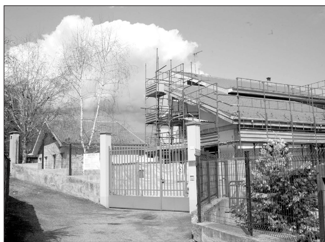
Proseguono i lavori di ampliamento della Scuola dell'infanzia Asilo Infantile "Guido Rocca Villa"
