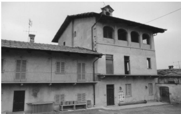
il fabbricato ex asilo già parzialmente utilizzato (battisti)
