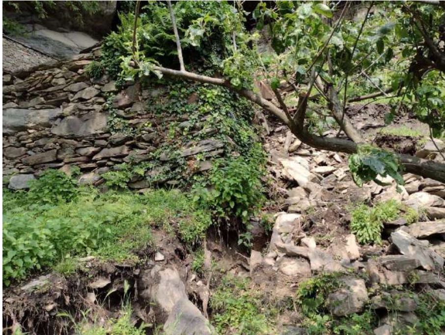
Foto 1: particolare del muro posto a sostegno del terrazzo sclazato.
